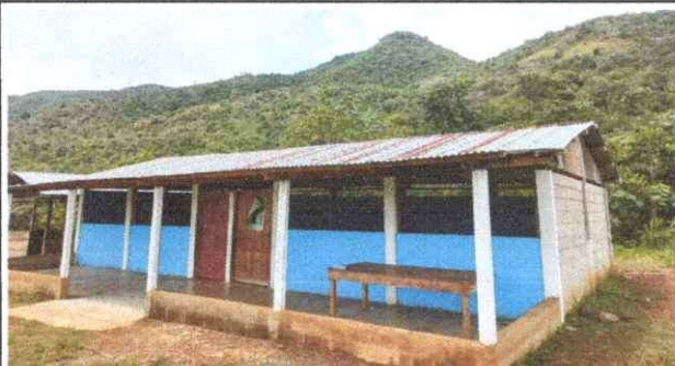
Foto 5: Reparación de banquetas de concreto, alrededor de las paredes para evitar que se ensucien con el lodo
