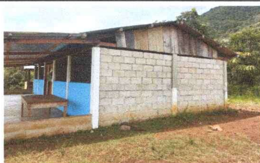
Foto 6: Se observa una parte de las paredes que necesita repello y cernido
